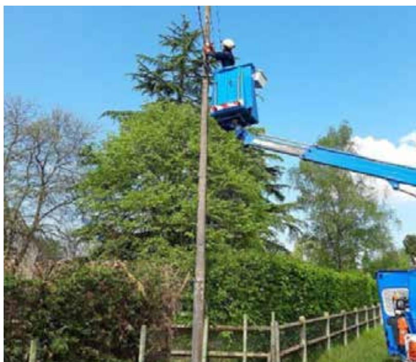
Intervention mi-avril 2020 sur la commune d'Ingrannes (45).
